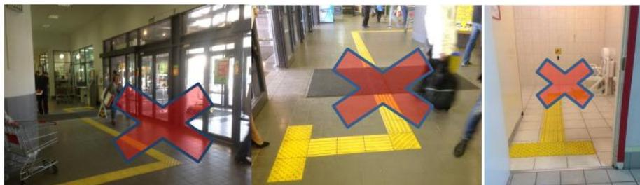
Фото 1, фото 2 – маршрут движения инвалида по зрению, выполненный в виде наклеенных на поверхность тактильных ПВХ плиток с различным рисунком (риффы в шахматном порядке, диагональные риффы, параллельные риффы), Фото 3 – маршрут движения инвалида по зрению в санузле, выполненный в виде наклеенных на поверхность тактильных ПВХ плиток с различным рисунком.
